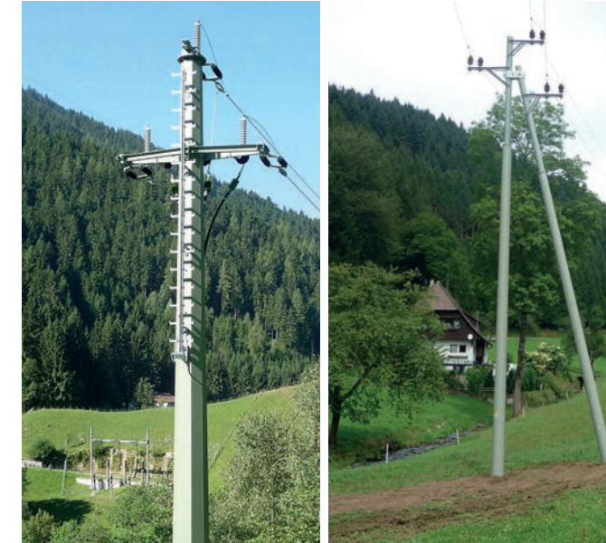
Tecpoles, „versorgt unsere Welt mit Energie!“
